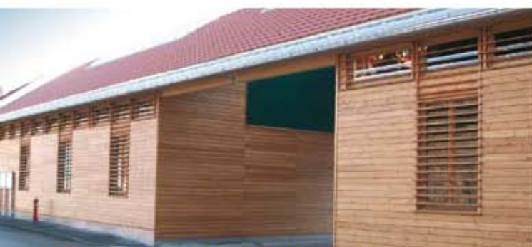
TREOLJE Holzöl verzögert den Vergrauungsprozess z.B. bei Lärchenholzfassaden erheblich.
