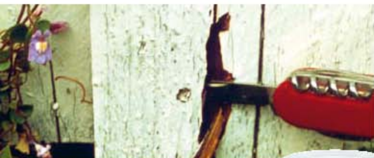
Holzfäule entsteht durch schlechten Holzschutz
